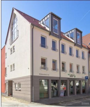
Neubau Wohn- und Geschäftshaus Soest, Grandweg 4
