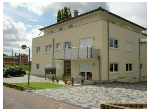
Neubau Mehrfamilienhaus Soest, Tappeweg 20-22
