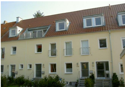
Umbau Fabrik zu Eigentumswohnungen Soest, Hoher Weg 17 c-f
