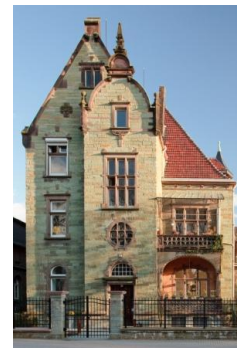
Sanierung Gründerzeitvilla Soest, Westenhellweg 11
