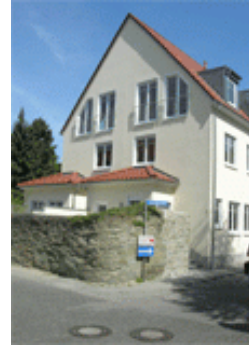
Neubau Doppelhaus Soest, Hoher Weg 17b / Thomäschäfergasse 1
